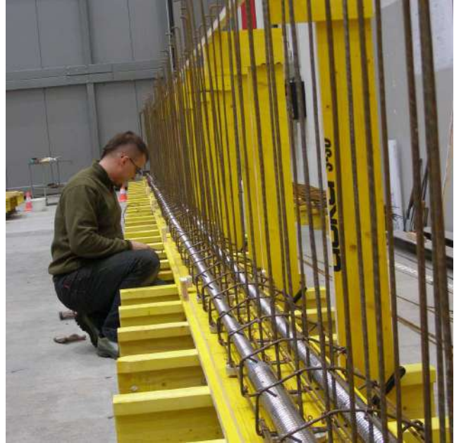
Rysunek 4.7. Przygotowanie szkieletów zbrojenia dźwigarów laboratoryjnych.
