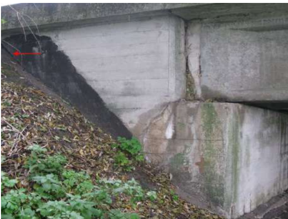
Rysunek 3.8. Obsunięcie nasypu skutkujące pęknięciem i przemieszczeniem przyczółka (Tarcopol, 2010).
