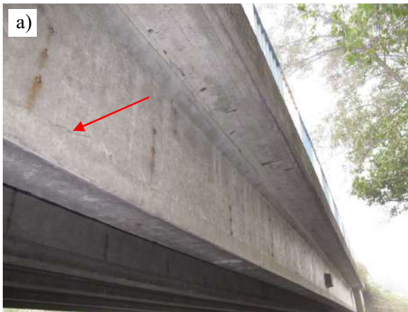
Rysunek 3.7. a) Zarysowanie betonu, b) Korozja zbrojenia (Tarcopol, 2010).
