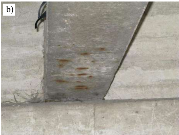
Rysunek 3.7. a) Zarysowanie betonu, b) Korozja zbrojenia (Tarcopol, 2010).
