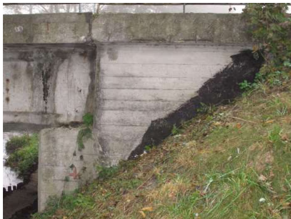
Rysunek 3.8. Obsunięcie nasypu skutkujące pęknięciem i przemieszczeniem przyczółka (Tarcopol, 2010).
