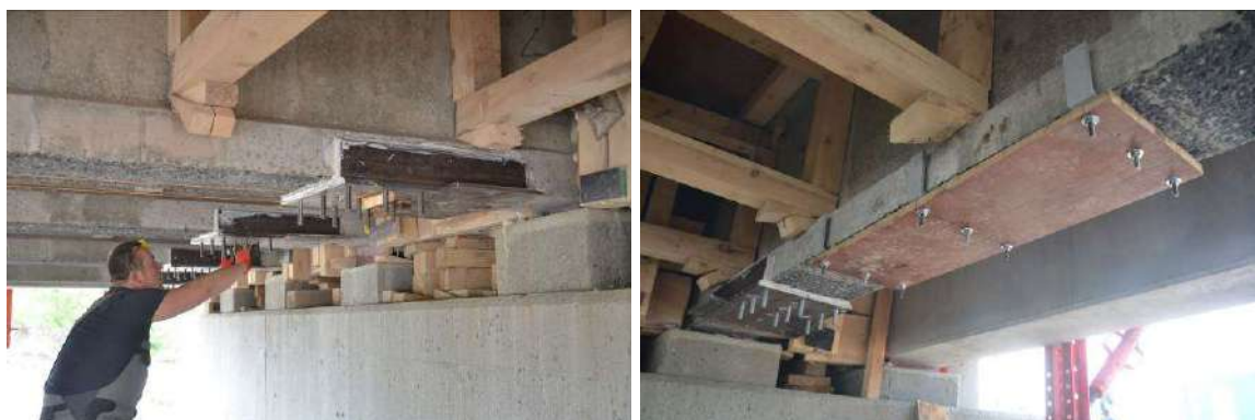
Rysunek 8.26. Trasowanie i klejenie kątowników z użyciem szablonów.
