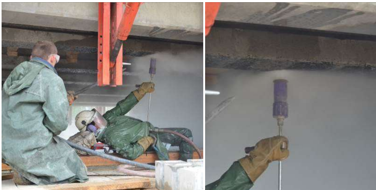
Rysunek 8.23. Hydromonitoring dźwigarów.
