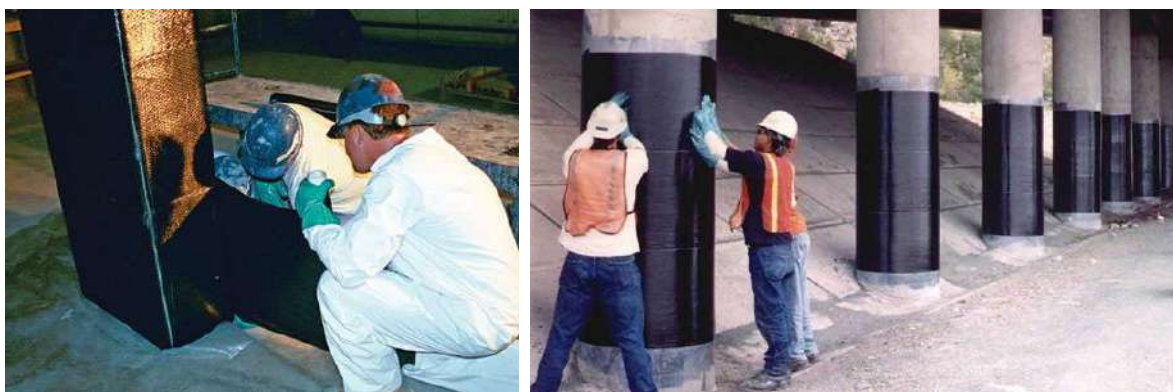
Rysunek 1.19. Przykłady wykonania wzmocnień obwodowych słupów żelbetowych (Alkhrdaji, 2015)
