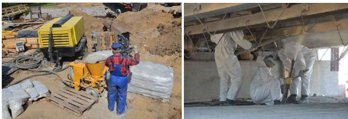
Rysunek 8.27. Reprofilacja dźwigarów metodą torkretowania na sucho.
