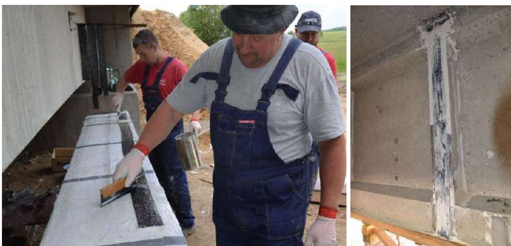
Rysunek 8.32 Aplikacja wzmocnienia na ścinanie przy użyciu mat kompozytowych.
