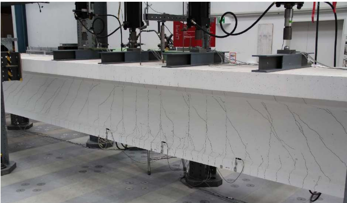
Rysunek 5.36. Zarysowanie dźwigara niewzmocnionego w strefie środkowej po zakończeniu badania.
