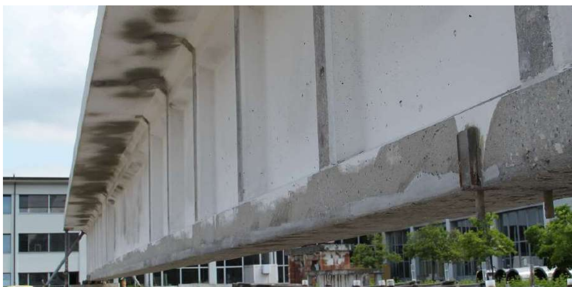
Rysunek 4.34. Widok dźwigara po wykonaniu reprofilacji.
