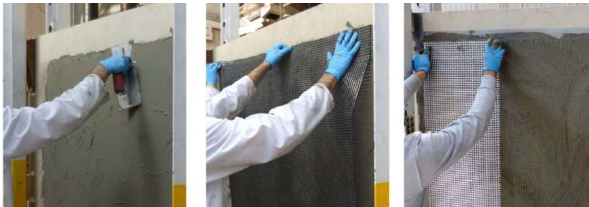
Rysunek 1.21. Przykładowe wykonanie wzmocnienia typu TRM z dwoma rodzajami włókien (Koutas, Bournas, 2016).
