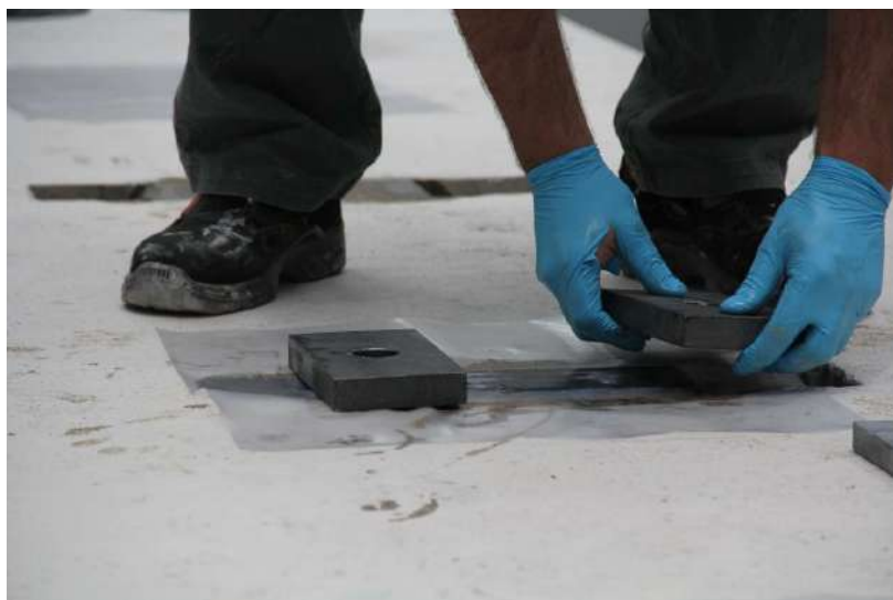
Rysunek 4.46. Łączenie końców mat CFRP na zakład na górnej powierzchni płyty.
