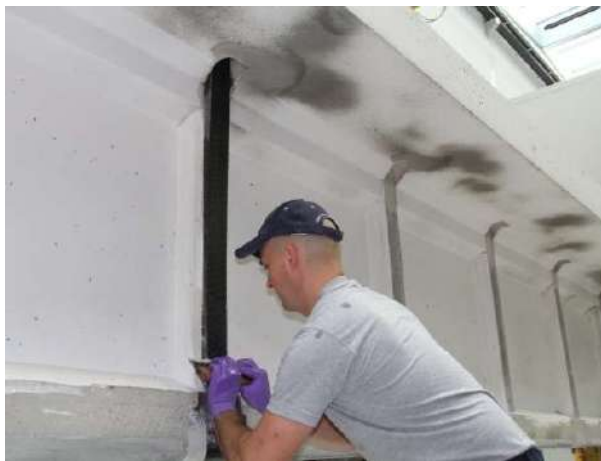
Rysunek 4.45. Przyklejanie oplotu na powierzchni dźwigara.
