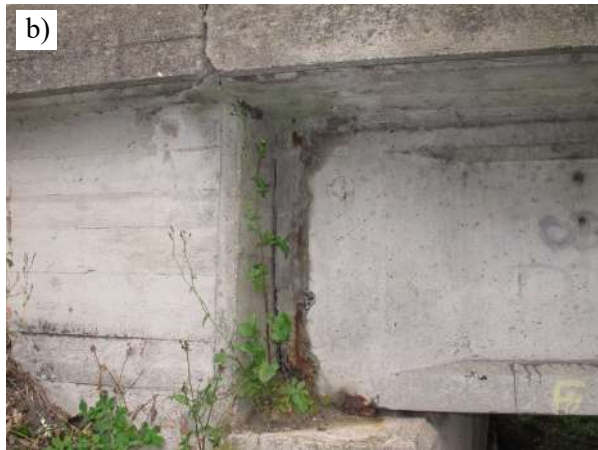
Rysunek 3.6. a) Korozja łożysk, b) Zanieczyszczenie szczeliny dylatacyjnej (Tarcopol, 2010).
