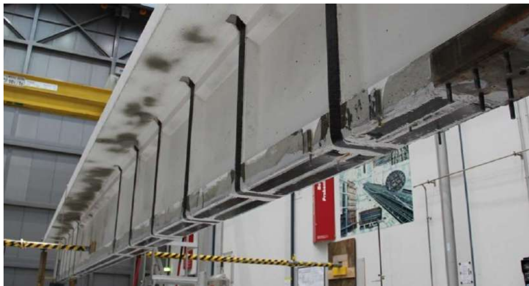
Rysunek 4.47. Widok dźwigara po wzmocnieniu.
