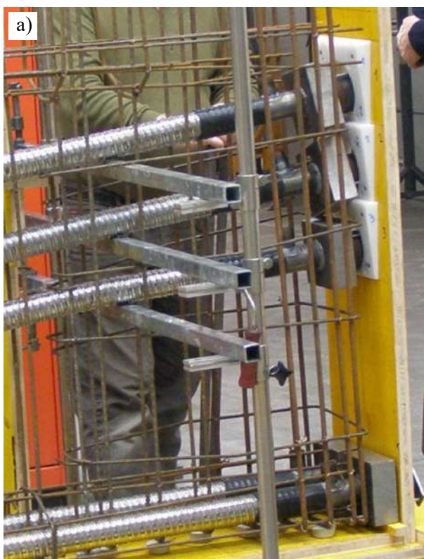
Rysunek 4.5. a) Głowice sprężające kabli zamontowane w deskowaniu, b) Widok przekładek do montażu głowic kabli.
