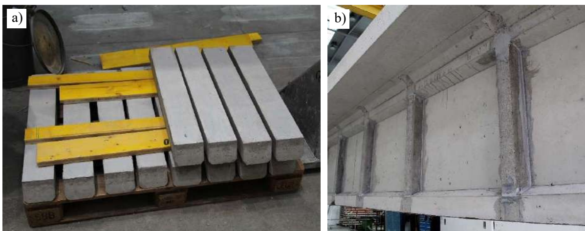
Rysunek 4.30. Betonowe bloki po rozformowaniu (a) i po przyklejeniu do powierzchni dźwigara (b).
