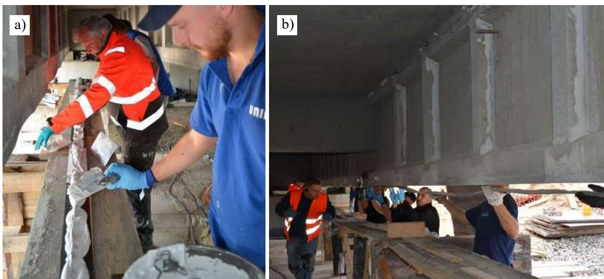
Rysunek 8.30. Nakładanie zaprawy klejowej (a) i przygotowanie taśmy kompozytowej do naprężenia (b).
