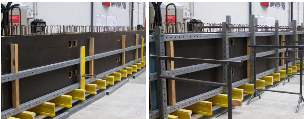
Rysunek 4.12. Montaż konstrukcji wsporczej dla szalunków.
