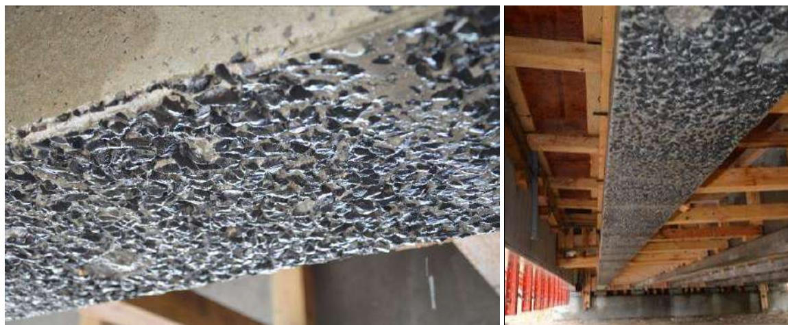
Rysunek 8.24. Powierzchnia dźwigarów po wykonaniu hydromonitoringu.
