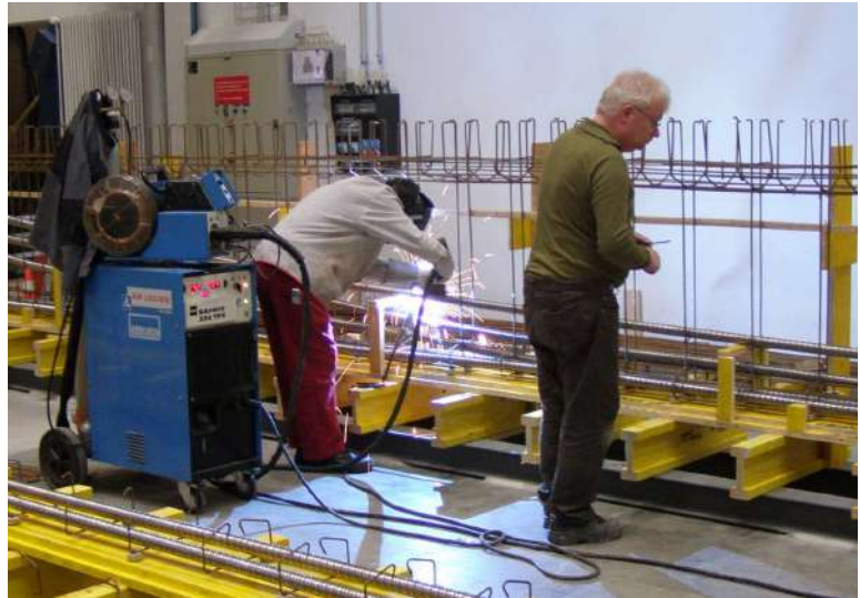
Rysunek 4.8. Montaż kabli sprężających.
