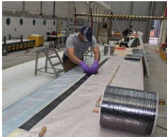
Rysunek 4.44. Impregnowanie i składanie odcinka maty CFRP na stole roboczym.
