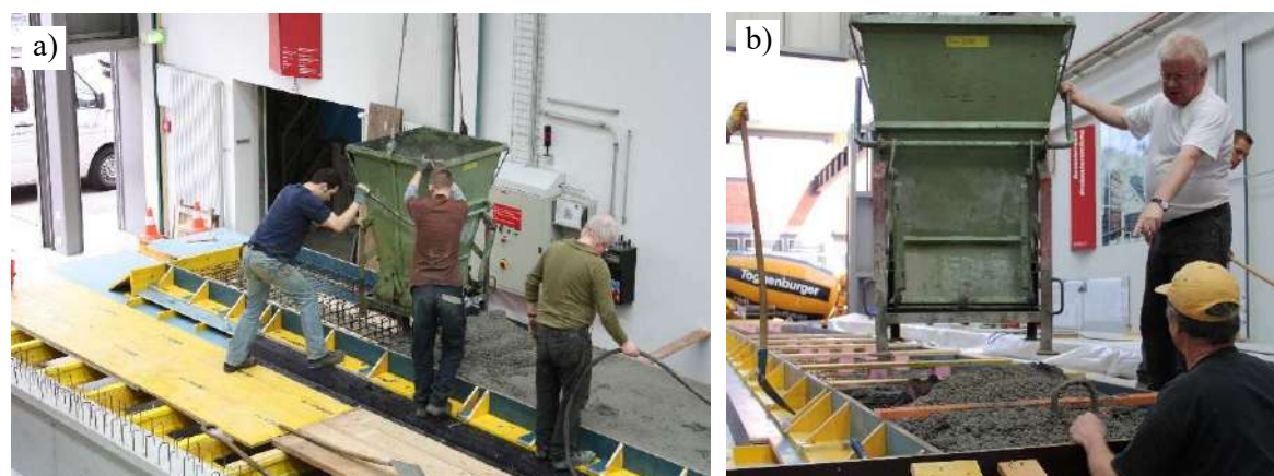
Rysunek 4.19. a) Betonowanie płyty dźwigara nr 1 (a) i dźwigara nr 2 (b).
