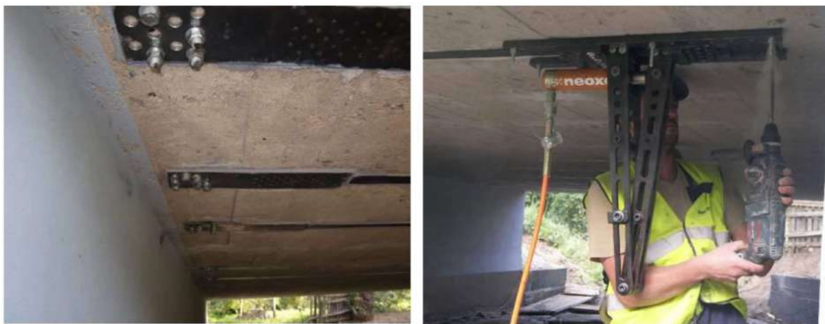
Rysunek 2.19. System Neoxe podczas aplikacji na moście w Przeclawicach (Siwowski, Żółtowski, 2012).
