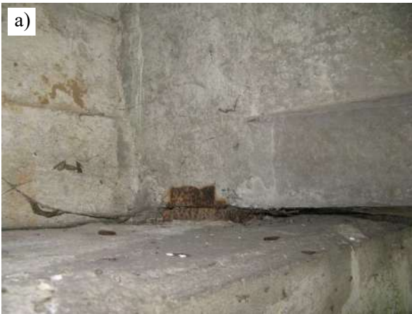
Rysunek 3.6. a) Korozja łożysk, b) Zanieczyszczenie szczeliny dylatacyjnej (Tarcopol, 2010).
