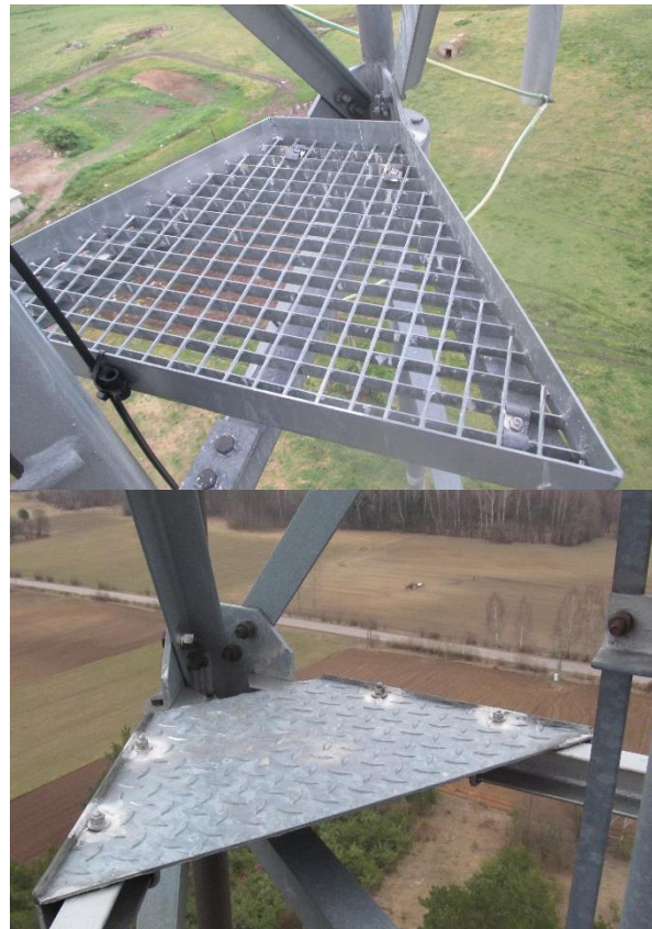
Fot. 2.19. Pomosty techniczne zlokalizowane wewnątrz trzonu wieży
