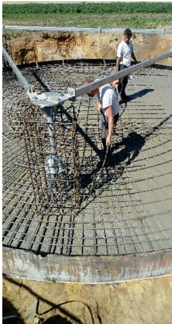
Fot. 2.16. Płyta fundamentowa okrągła
