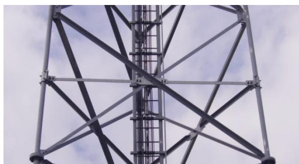
Fot. 2.24. Istniejące wzmocnienie konstrukcji wieżowej poprzez skrócenie długości wyboczeniowych jej krawężników
