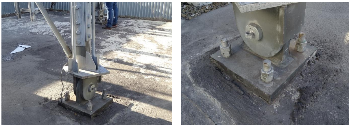
Fot. 2.13. Połączenie podporowe wieży, której montaż przeprowadzany jest przez obrót trzonu w węzle
