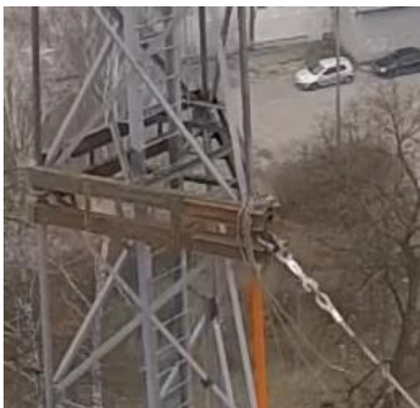
Fot. 3.4. Stalowa przepona
