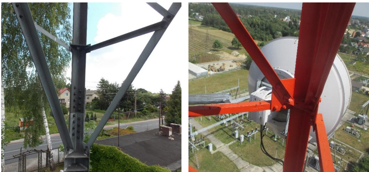
Fot. 2.2. Połączenie pomiędzy krawężnikami z zastosowaniem nakładek (po lewo) oraz połączenia krzyżulców z krawężnikiem za pomocą blach węzłowych i żeber poziomych (po prawo); krawężniki i krzyżulce wieży wykonane z kątowników gorącowałcowanych
