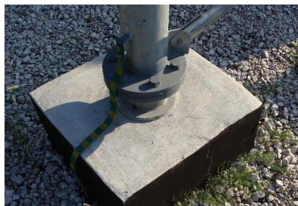
Fot. 2.10. Połączenie podporowe kołnierzowe wyniesione ponad powierzchnię fundamentu; kotew wykonana z pręta pełnego usztywniona rurą
