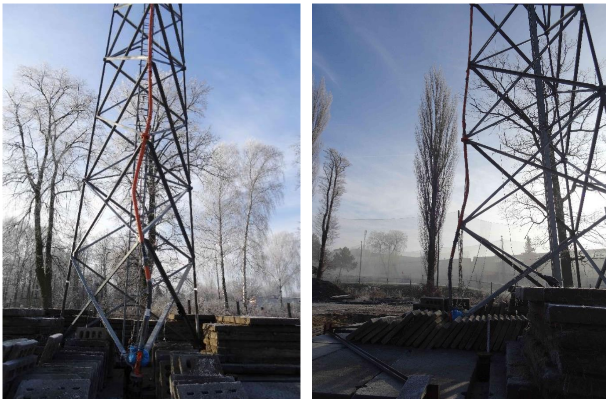
Fot. 3.6. Wyboczony krawężnik segmentu S-7: widok z przodu (po lewo) oraz z boku (po prawo)
