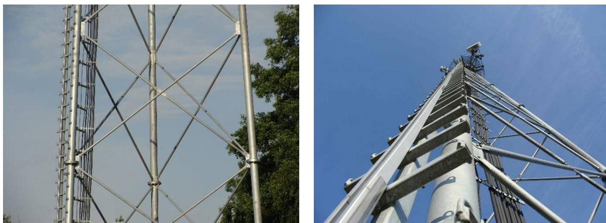
Fot. 2.23. Zlokalizowane na krawężniku wieży drabina włazowa (po stronie zewnętrznej) i wsporniki kablowe (wewnątrz trzonu)
