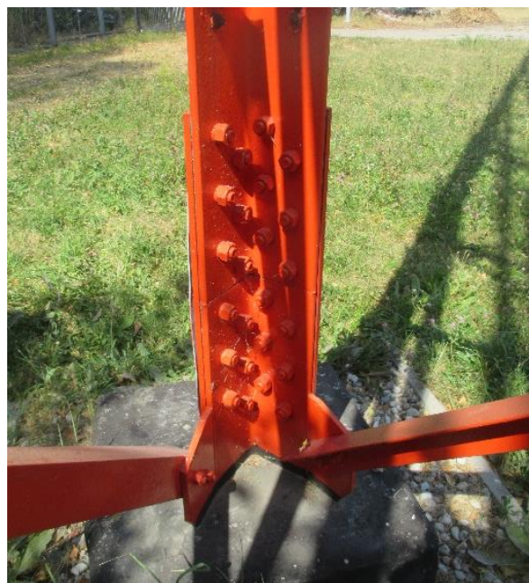
Fot. 2.12b. Połączenie podporowe zakładkowe: kotwa i krawężniki wykonane z kątowników
