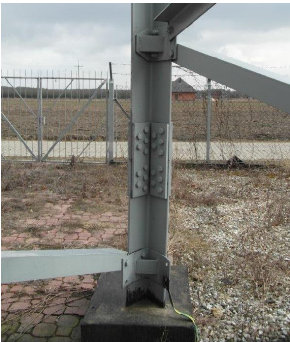
Fot. 2.12a. Połączenie podporowe zakładkowe: kotwa i krawężniki wykonane z kątowników
