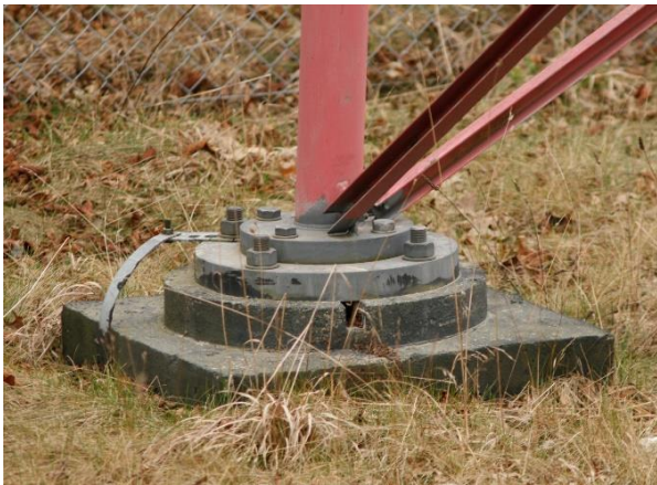
Fot. 2.11. Połączenie podporowe: blacha podstawy zamocowana do fundamentu za pomocą śrub kotwiących
