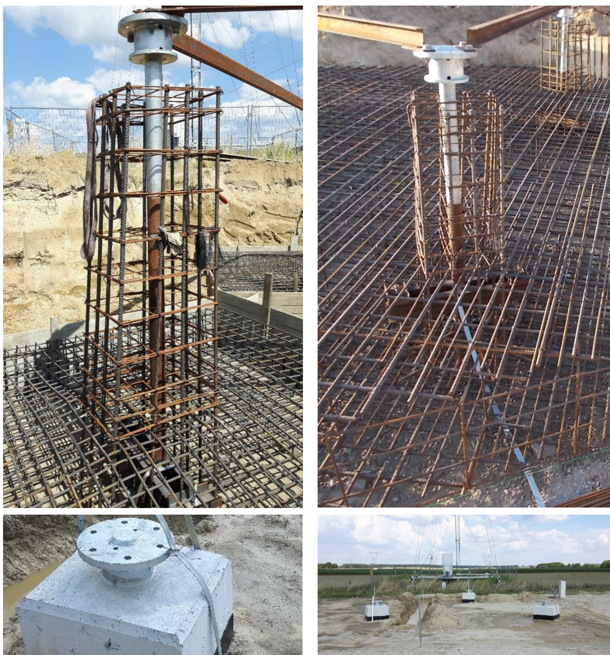
Fot. 2.7. Kotwy fundamentowe wykonane z kształtowników umieszczone w zbrojeniu fundamentu stopowego (na górze po lewo) oraz płytowego (na górze po prawo); wystające części kotew po zabetonowaniu fundamentów (na dole)
