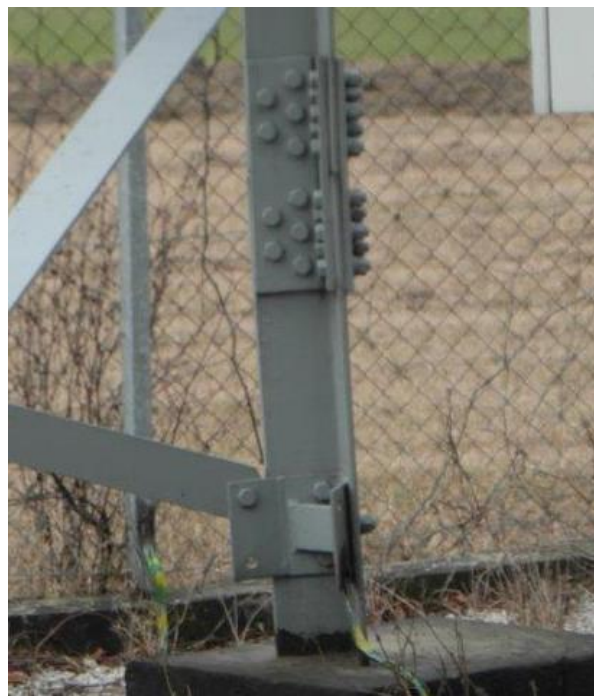
Fot. 2.12a. Połączenie podporowe zakładkowe: kotwa i krawężniki wykonane z kątowników
