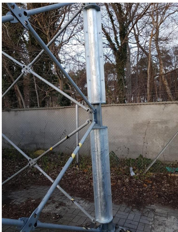
Fot. 2.26. Istniejące wzmocnienie przekroju krawężników wykonanych z rur
