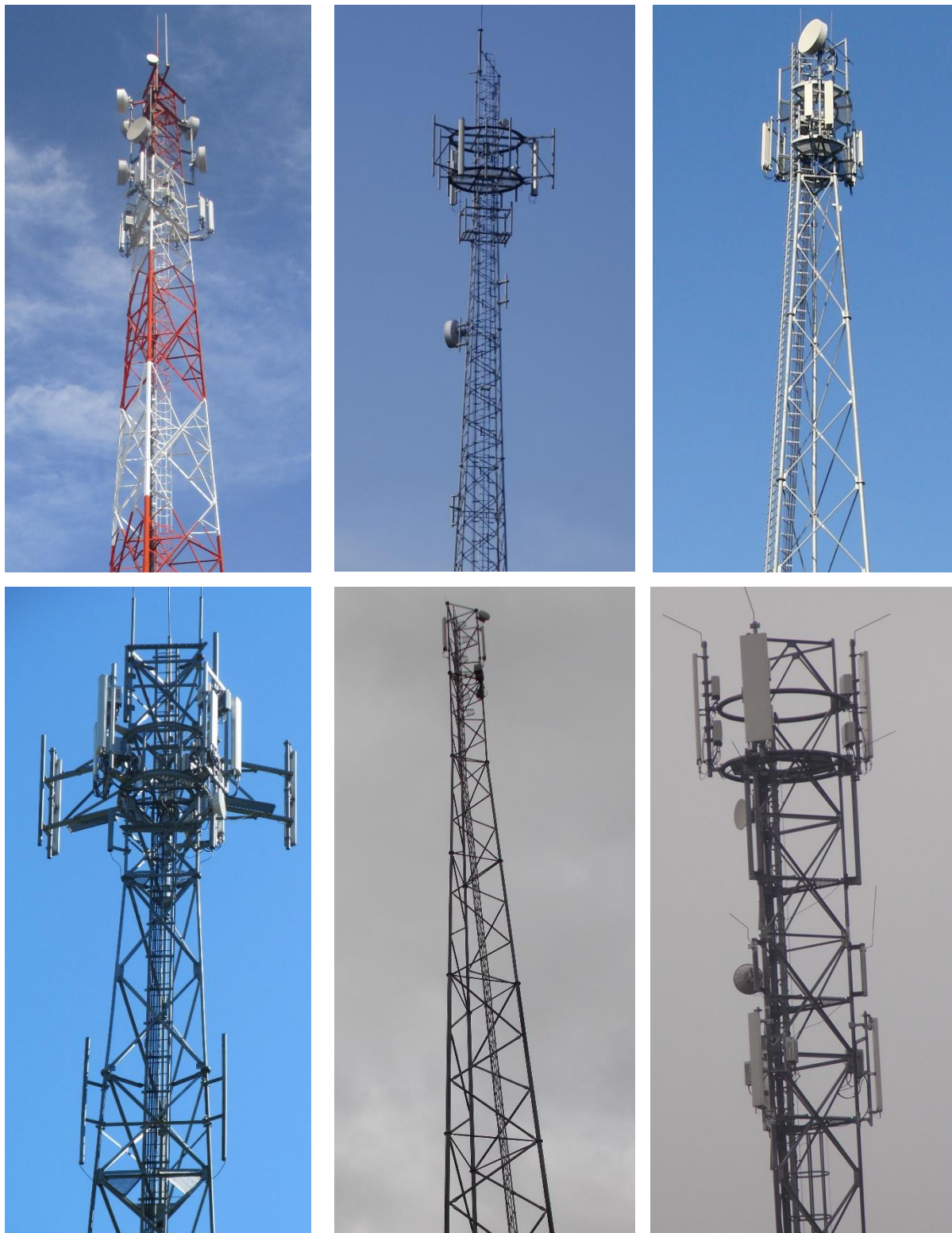
Fot. 2.17a. Stacje bazowe zlokalizowane na różnych typach konstrukcji wieżowych
