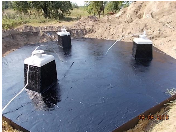
Fot. 2.15 Płyta fundamentowa w kształcie trójkąta ze ściętymi narożnikami
