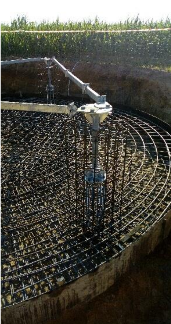
Fot. 2.16. Płyta fundamentowa okrągła
