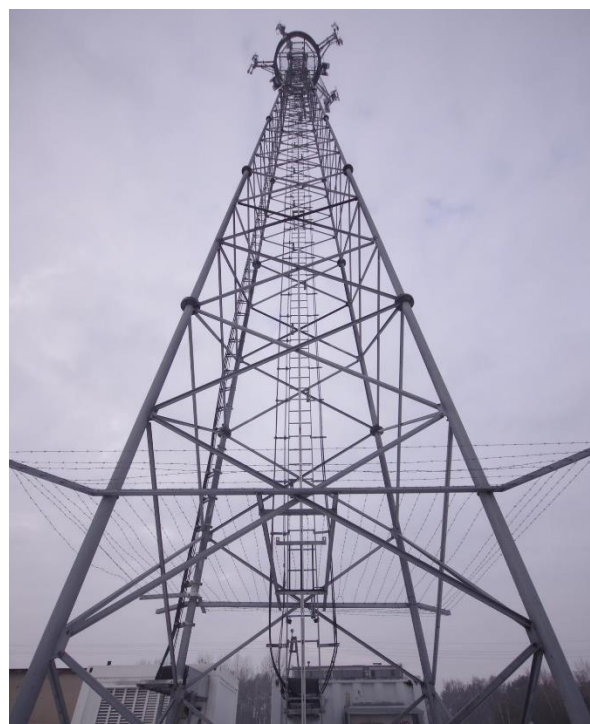
Fot. 2.21. Drabiny włazowe: z samodzielnym fundamentem (na górze), zamocowana na ścianie wieży (na dole)
