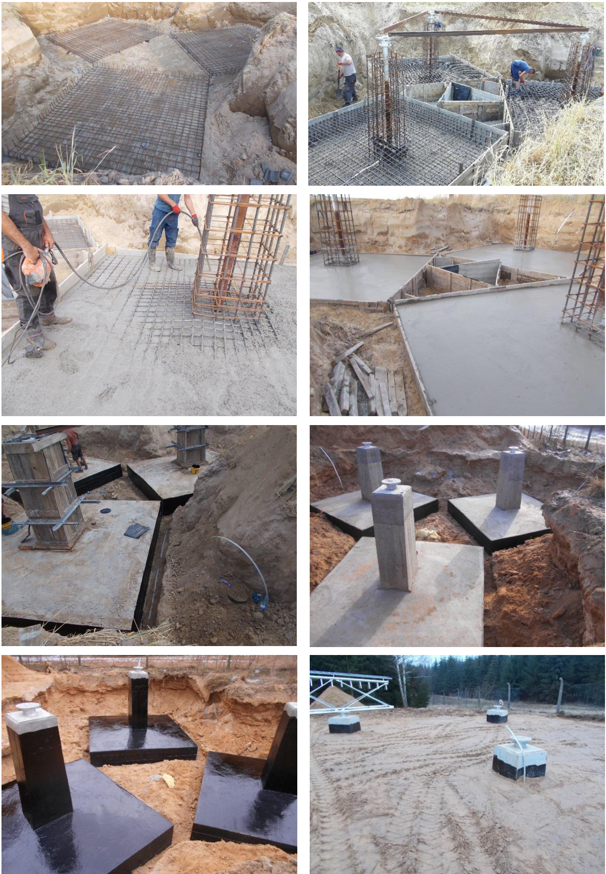
Fot. 2.14. Etapy wykonywania fundamentów stopowo-płytowych
