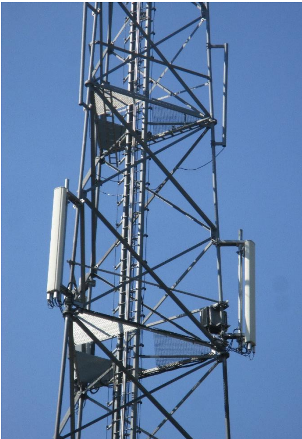
Fot. 2.19. Pomosty techniczne zlokalizowane wewnątrz trzonu wieży
