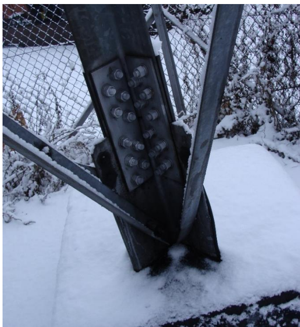
Fot. 2.12b. Połączenie podporowe zakładkowe: kotwa i krawężniki wykonane z kątowników
