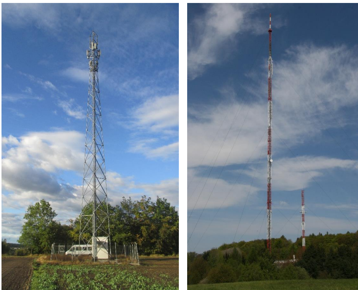
Fot. 2.1. Wieża kratowa (po lewo) i maszt (po prawo) – widoczne różnice w schemacie statycznym trzonu i w powierzchni zabudowy
