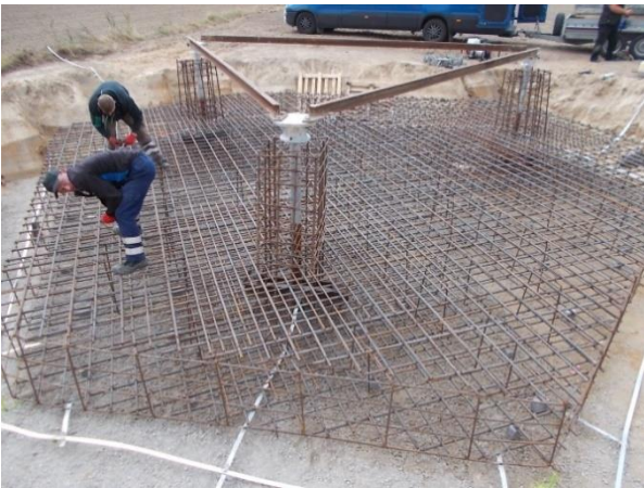
Fot. 2.15 Płyta fundamentowa w kształcie trójkąta ze ściętymi narożnikami
