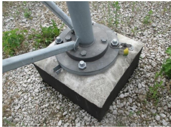
Fot. 2.11. Połączenie podporowe: blacha podstawy zamocowana do fundamentu za pomocą śrub kotwiących
