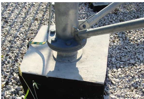
Fot. 2.10. Połączenie podporowe kołnierzowe wyniesione ponad powierzchnię fundamentu; kotew wykonana z pręta pełnego usztywniona rurą
