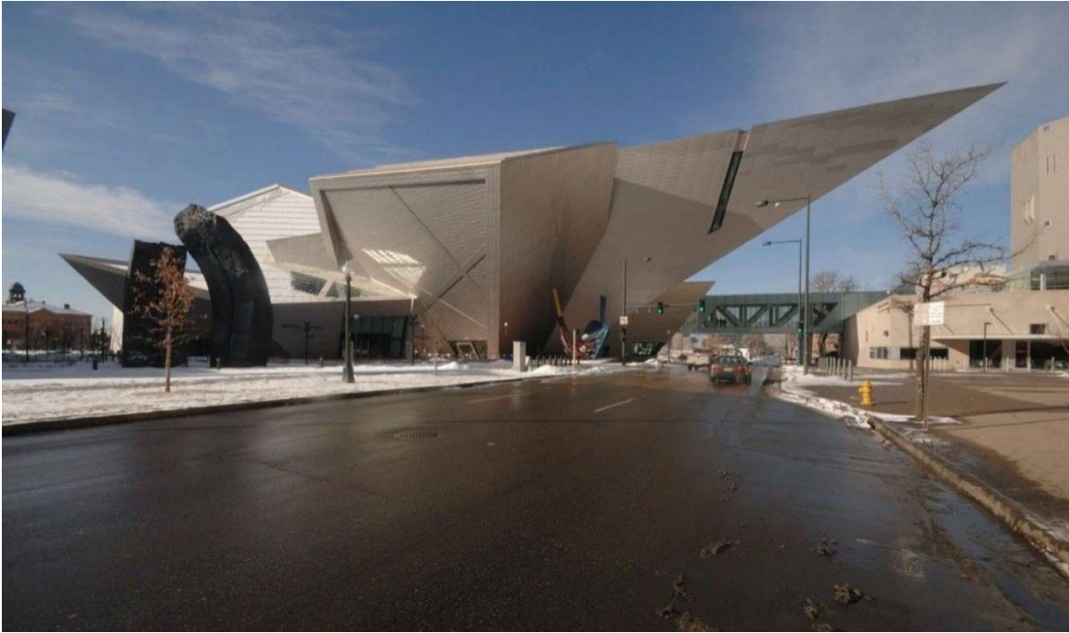
Ilustracja 14 Oryginalność budynku dekonstruktywistycznego pokazana z dużej odległości. Muzeum sztuki w Denver, Kolorado, pracownia Libeskinda.
