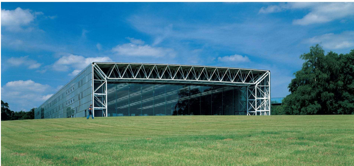
Ilustracja 27 Elewacja budynku budząca skojarzenie z przekrojem przez konstrukcję budynku. Rozbudowa Sainsbury Centre w Norwich, Anglia, pracownia Foster.
