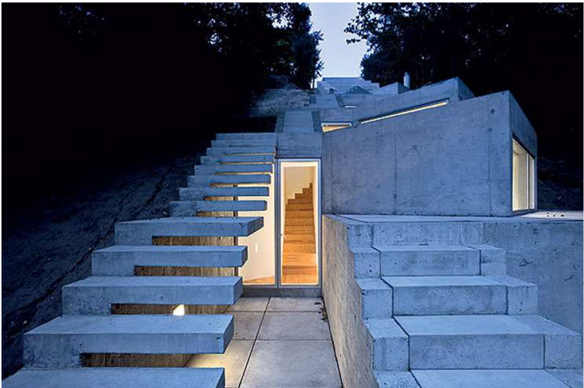
Ilustracja 9 Schody ograniczone do stopnic. Tolo House w Ribeira da Pena, Portugalia, pracownia Álvaro Siza Vieira.
