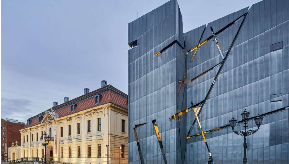
Ilustracja 17 Rany i pęknięcia na elewacji. Muzeum Żydowskie w Berlinie, pracownia Libeskinda.
