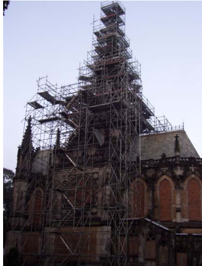
Rys.3. Przykładowe rusztowanie niekotwione przy Kaplicy Scheiblera w Łodzi.
