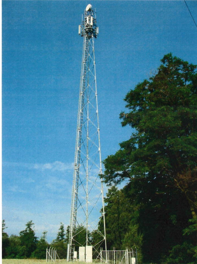
Fot. 1. Sylwetka wieży o wysokości 40 metrów.
