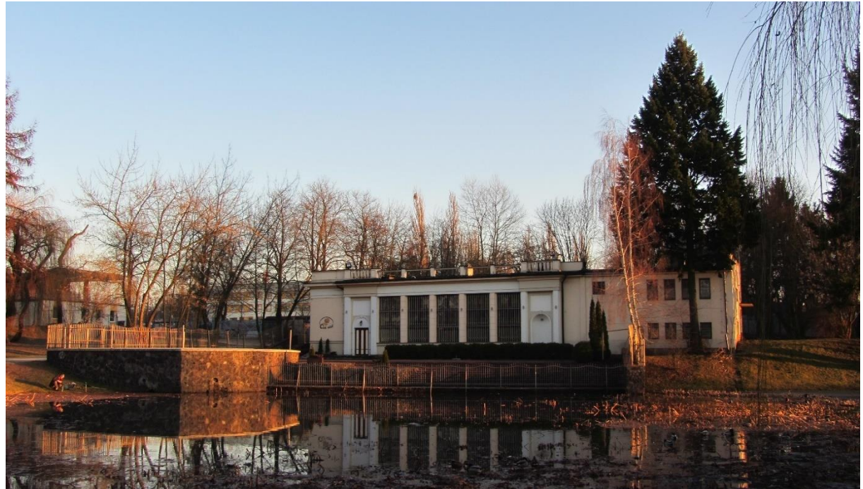
Otwarta pływalnia KS „UNIA”, zespół wypoczynkowy dla pracowników „Anilany” źródło: materiały Miejskiej Pracowni Urbanistycznej w Łodzi
